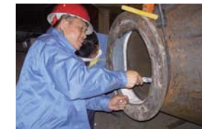
旋流器原煤桶出口溜槽
